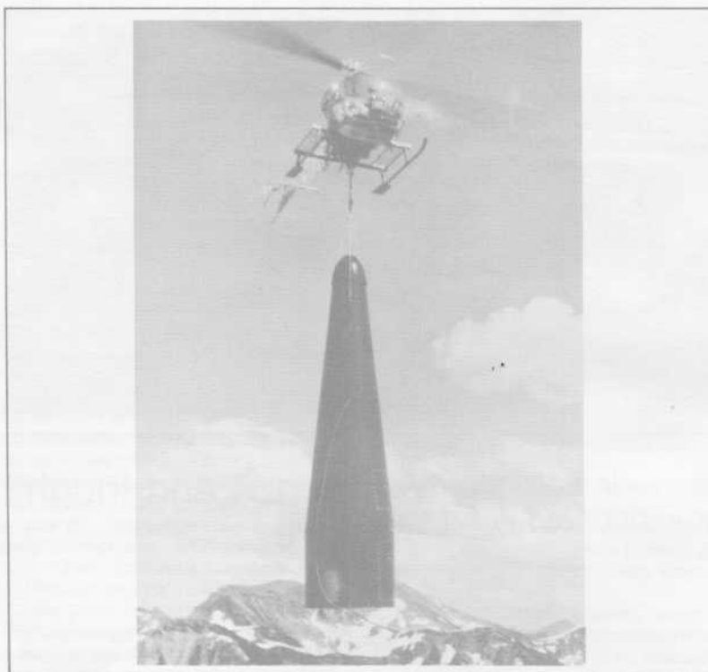
Les répéteurs sont protégés par des cloches en fibre de verre mesurant 8,5 mètres de haut. Certains de ces répéteurs ne sont accessibles que par hélicoptère (Photo: B.C. Hydro)
