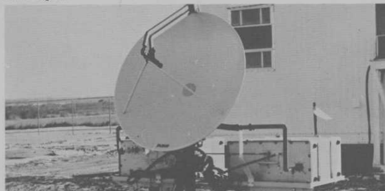
Une station terrienne à antenne parabolique d'un mètre de diamètre New ground station with one-metre dish
